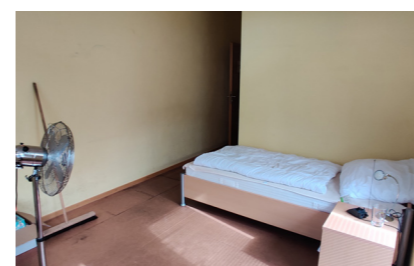
Vorheriger Ruheraum Alte Möbel und Bodenbeläge
