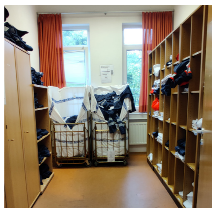
Umkleideraum (vorher) Altes Mobiliar und alte Bodenbeläge
