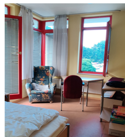
Ruheraum (vorher) Alte Möbel, Bodenbeläge und Fenster
